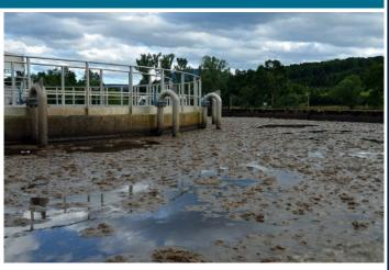
Dans l'ordre nous avons pu voir l'arrivée des eaux usées, la séparation des sables et des graisses, le bassin biologique qui traite avec des bactéries cette eau, puis le bassin de séparation entre les boues et l'eau claire pouvant être rejetée dans le Giessen, la rivière passant dans le Val de Villé.
